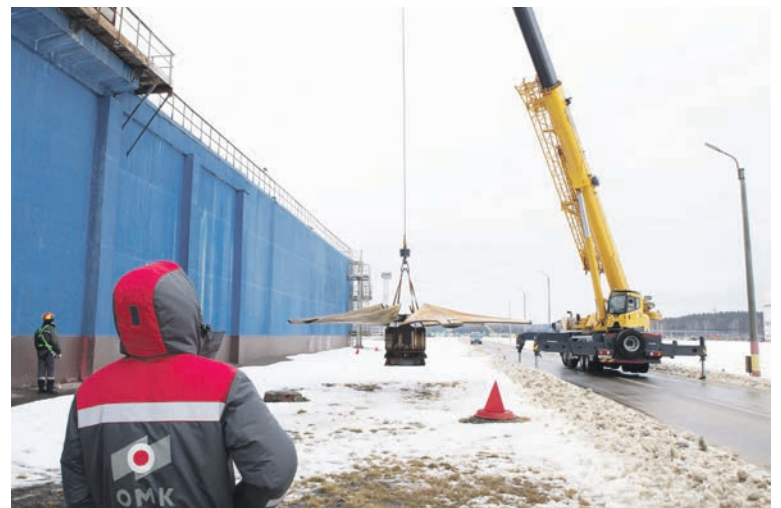
△ Снять вентилятор смогли только с помощью автокрана © ВАЛЕРИЙ ПОКУМЕЙКО
